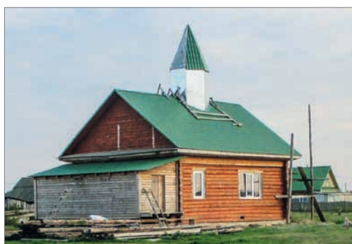
Мечеть на стадии строительства
