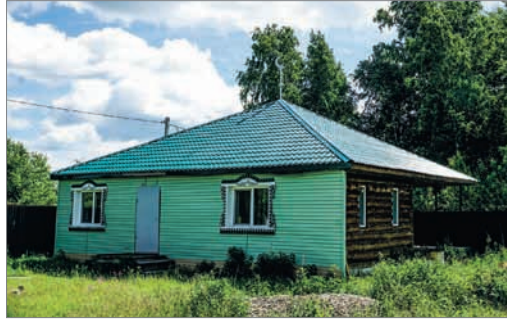
Мечеть на стадии строительства
