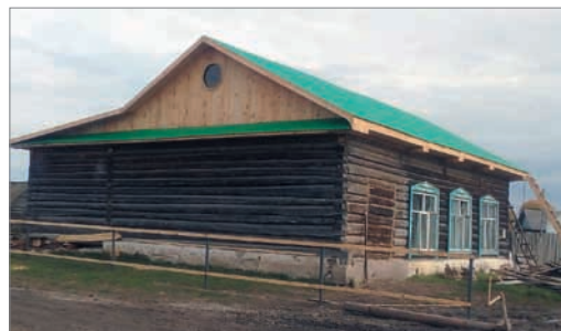
Мечеть на стадии строительства
