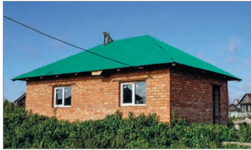
Мечеть на стадии строительства
