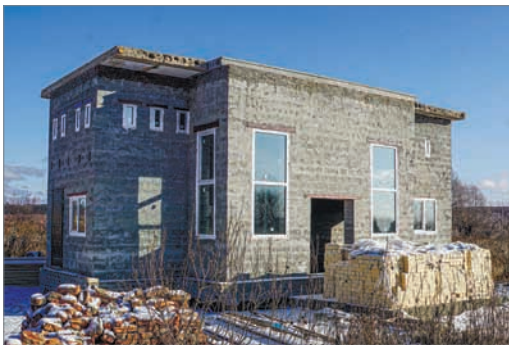
Мечеть на стадии строительства
