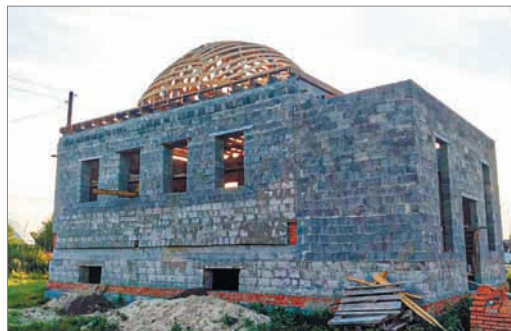
Мечеть на стадии строительства
